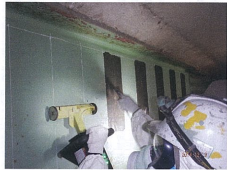
写真二 塗膜剥離施工状況(橋梁)
